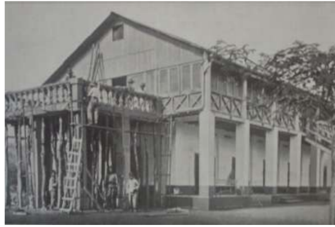
Travaux de la maison de l'administrateur français à Abomey au Dahomey 5
